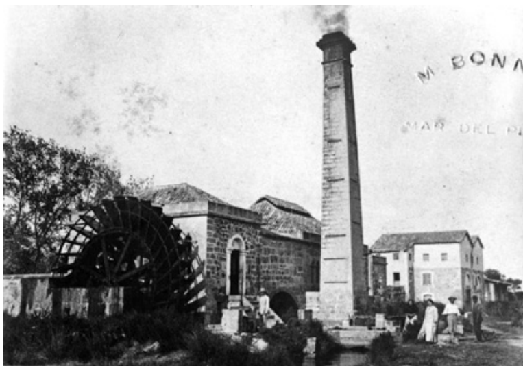
En primer pla, la màquina hidràulica per dessecar l'Albufera. Al fons, la fàbrica de paper. 1920. AMD.
