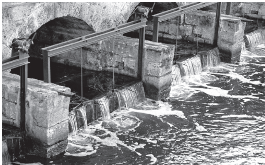
Comportes que regulen el pas d'aigua. Ubicades entre el canal del Sol i el Gran Canal. Arxiu Llabrés.
