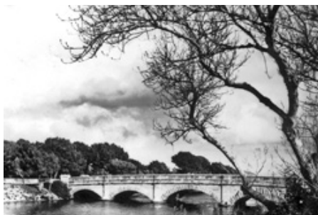
Pont dels anglesos, o de les casetes o de les comportes. ARM-AT294.
