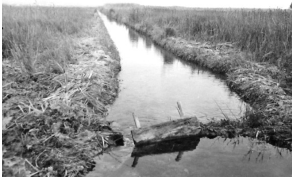
Detall d'una síquia taponada amb una post, que fa de portella. La distribució de l'aigua a les finques era un dels aspectes més importants. ARM-AT 294.
